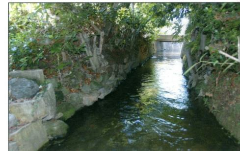
女夫岩と苧漕場より小高い所に、常盤池からの「幹線水路」があり常盤池が築堤された当時の水路が唯一残っている。他の水路はコンクリートで改修されている。
